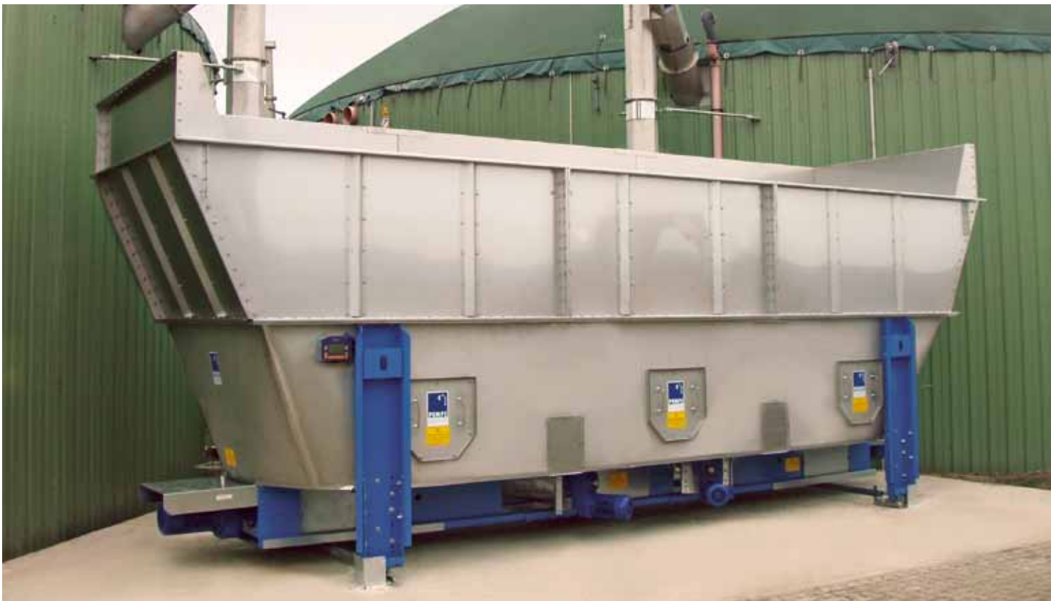
Feststoffdosierer Typ 500 mit zwei 3-teiligen Schneckensträngen Typ 360 zur Beschickung von zwei Fermentern
